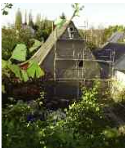
...et le pignon complètement isolé
