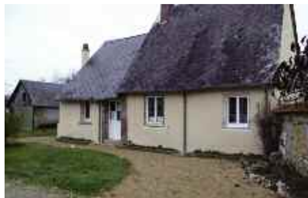
Le crépis de la bibliothèque a été refait...
