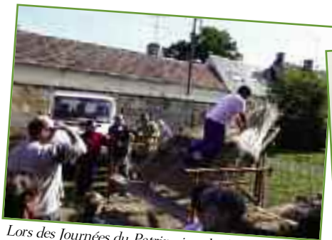
Lors des Journées du Patrimoine, les Joviens ont pu découvrir les techniques de construction ancienne : mur en bauge et couverture en chaume
