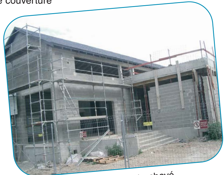
Le gros oeuvre est achevé
